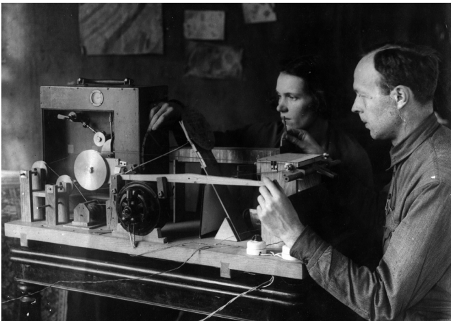
Abb. 4: Evgeny Sholpo und seine Frau Olga arbeiten mit der ersten Version des Variophons 1932. © Marina Sholpo.
